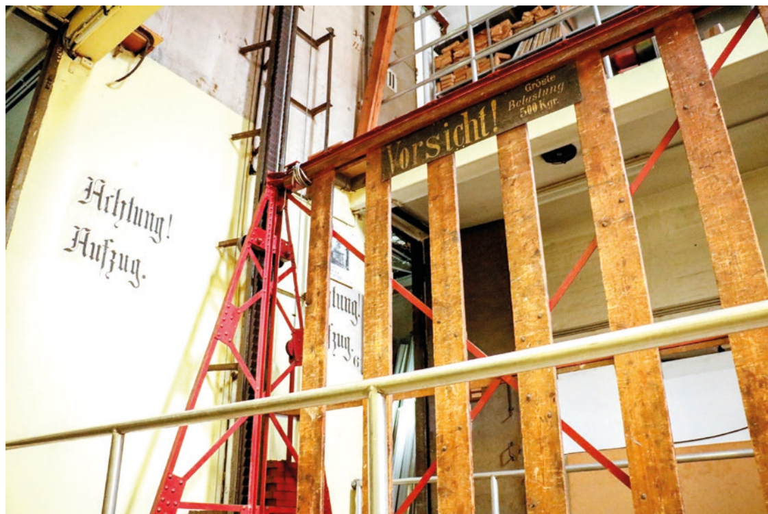
Der Wasserlift, ein historischer Teil der Grazer Oper.
